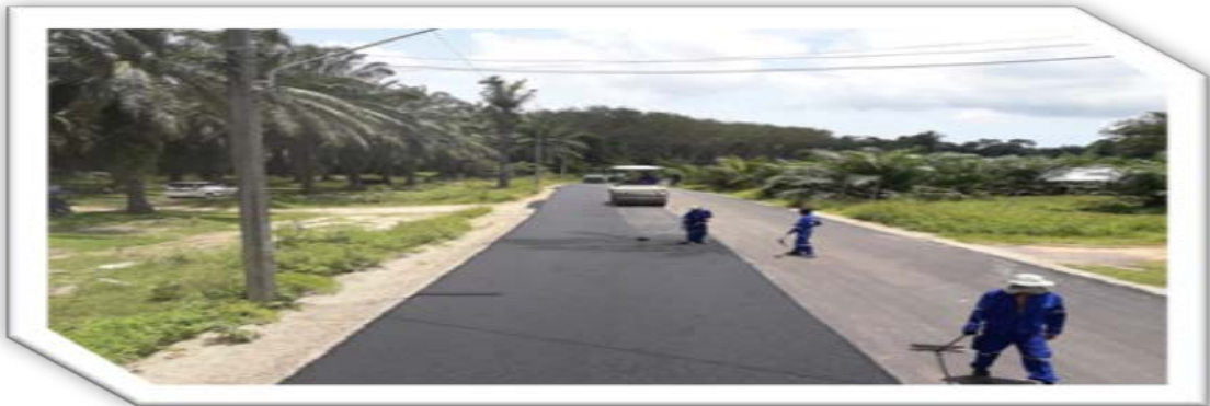
โครงการก่อสร้างถนนกึ่งวงรีวงเมืองน่านฟ้าจังหวัดคอนสารโดยกรมการขนส่ง- บ้านนาสาร หมู่ที่ ๘ - หมู่ที่ ๙(MOC)
